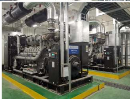
10*1600kW 0.4kV 50Hz Open Type
