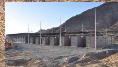
7*1600kW 10.5kV 50Hz Container type
