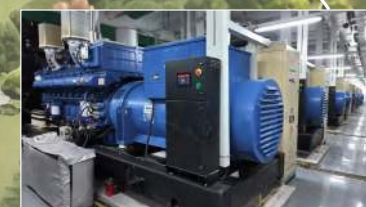
112*2000kW 10.5kV 50Hz Open Type
